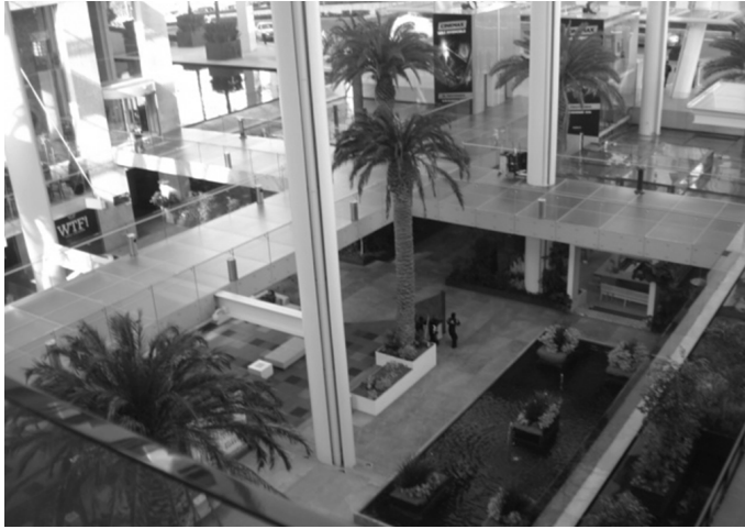
Figura 38. Pisos de cristal como muestra de vanguardia, que en contacto con el agua resultan excluyentes y altamente peligrosos
