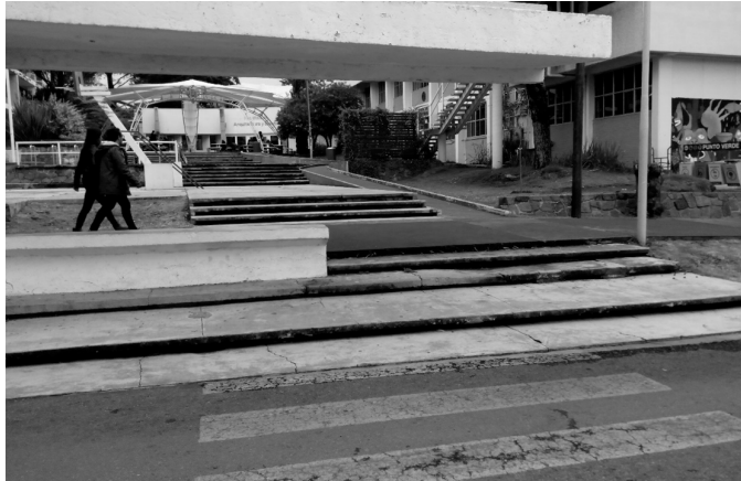
Figura 35. Ausencia de la cadena de accesibilidad en la discontinuidad de la rampa
