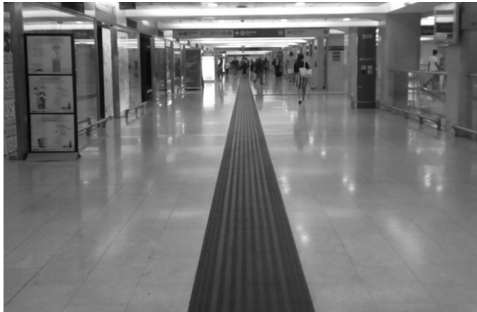
Figura 32. Losetas continuas que escasamente existen en el mercado y que sí cumplen las necesidades de las personas con discapacidad visual
