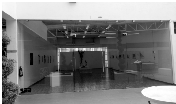
Figura 37. Cancelas de vidrio o cristal estructural, material que no cumple con criterios de seguridad ni accesibilidad universal porque puede provocar confusiones e impactos
